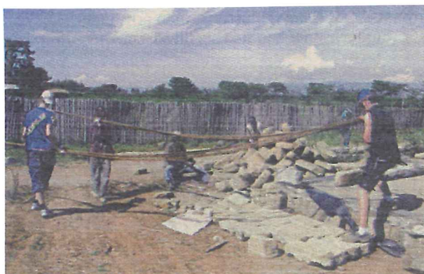
Tillsammans. Eleverna från byggskolan arbetade tillsammans med lokala byggnadsarbetare.
